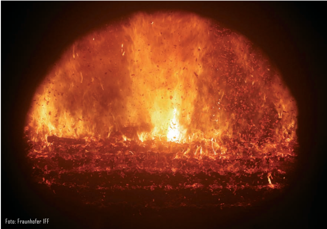
Blick in die Brennkammer einer Biomassefeuerung. Bei der Verbrennung entsteht ein Rauchgas, das sich zur Erzeugung von Wärme oder aber auch zum Betrieb eines ORC-Moduls zur Stromproduktion nutzen lässt.
