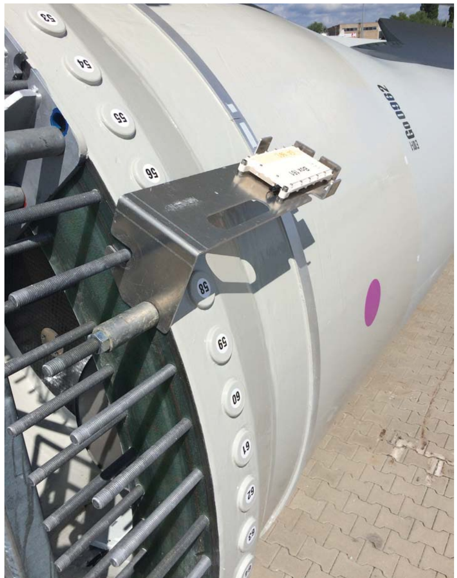
Der RFID-Chip am Bauteil enthält seine digitale Lebensakte und funkt seine Position an den zentralen Server, sobald das Bauteil bewegt wurde.
