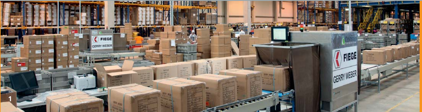
1 RFID-Tunnelgates im Einsatz im FIEGE-Megacenter Ibbenbüren.
